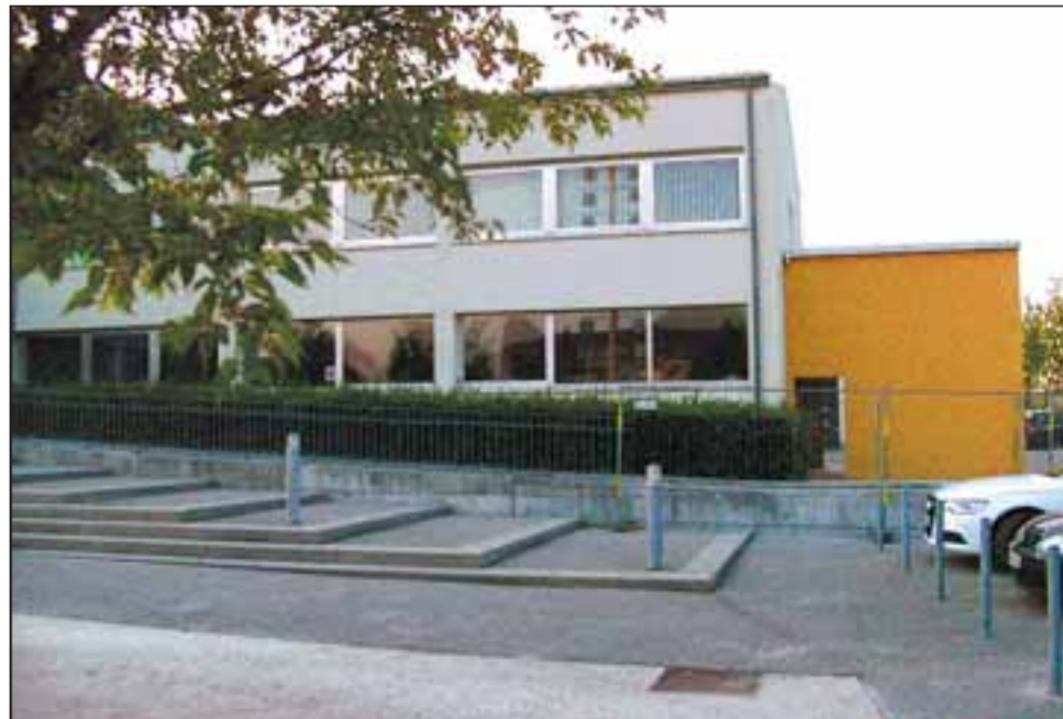
Der Anbau zur Unterbringung des dritten Siegelbacher Feuerwehrfahrzeugs ist bereits erkennbar (rechts), in sechs bis acht Wochen soll die Halle fertig sein. Der Trakt für die neuen Umkleiden wird nun allerdings erst in einem Jahr begonnen werden. Foto: Beck
